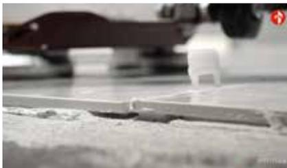
Posa a giunto aperto: sempre, e specialmente nella posa in ambienti con livelli di sollecitazione meccanica e igrotermica elevati. Riduce il modulo di elasticità della piastrellatura, riducendo il rischio di sollevamento, distacco o fessurazione della pavimentazione finita.
